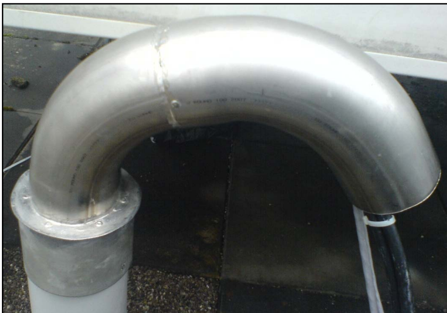
Figure 4 : Passage des câbles du toit au local technique
